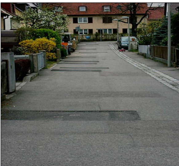
Bild 4: „Flickenteppich nach Aufgrabungen (FGSV)
